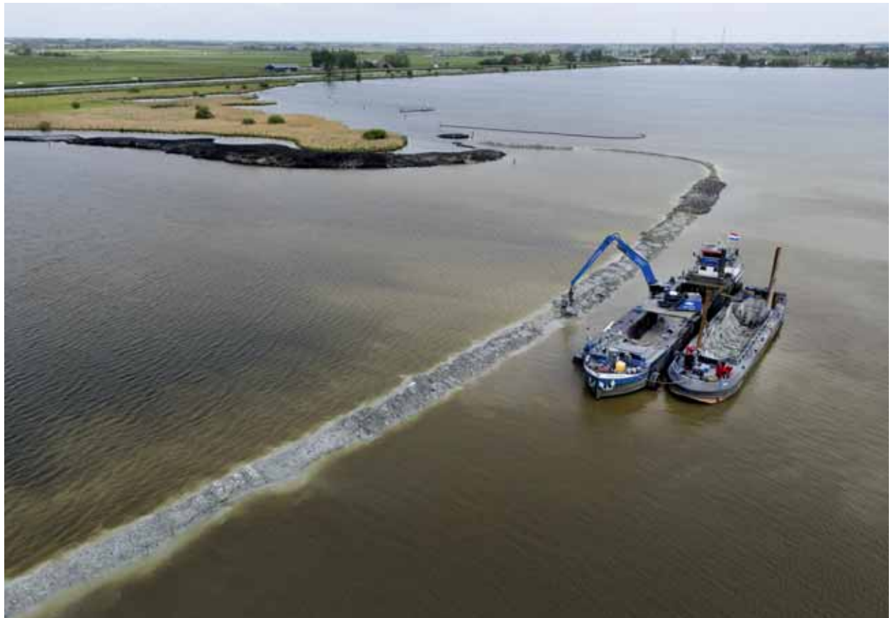
7 mei 2025. Bij de aanleg van een dam in een nieuw natuurgebied Saskerleidendam in het Alkmaarder- en Uitgeestermeer wordt vijftigduizend kuub granuliet in het meer gestort © Olaf Kraak / ANP foto
